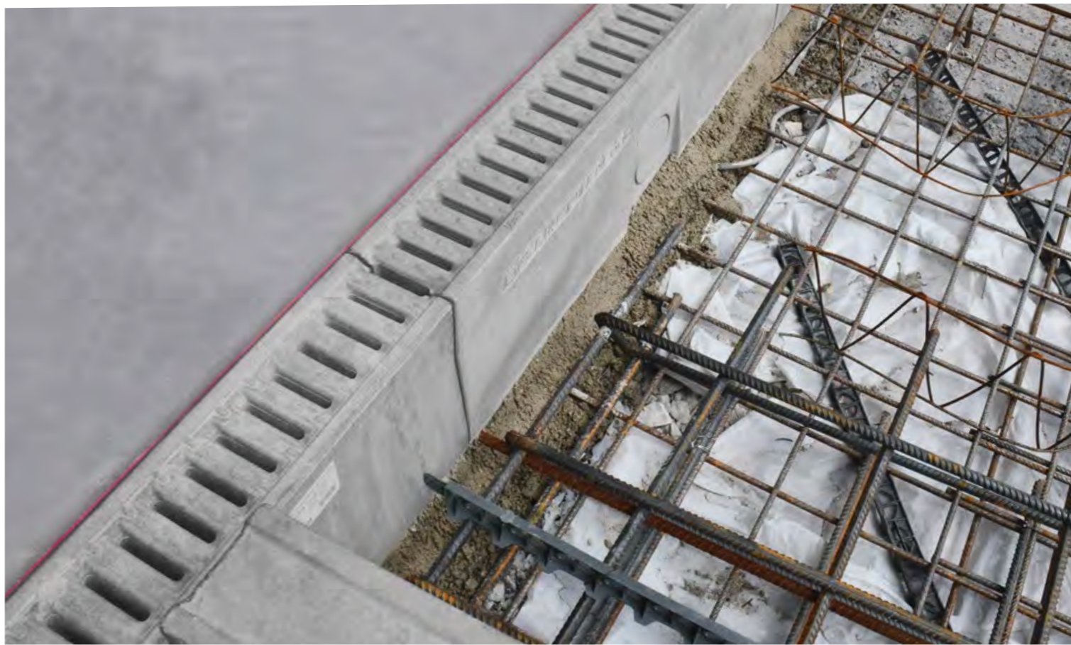
Unidad de sumidero, de una pieza, incl. rejilla de fundición dúctil, cubeta de sedimentos, salida DN 150
