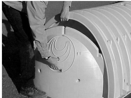
Figura 2. Colocación de las tapas
