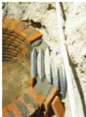
Figura 20. Conexión a pozo con empaques de valle
