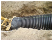
Figura 12. Empuje con maquinaria
