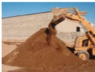
Figura 16. Colocación y compactación simétrica por capas
