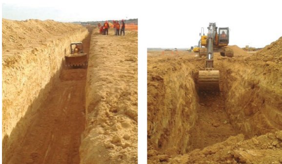
Figura 5. Excavación de la zanja
