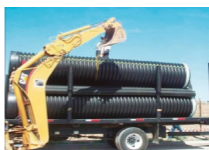
Figura 2. Descarga con maquinaria de 24 a 60 pulgadas
