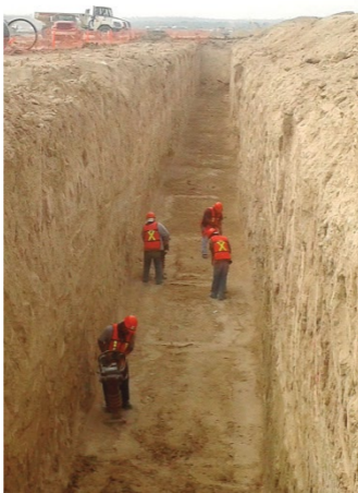
Figura 7. Compactación de encamado con equipo portátil
