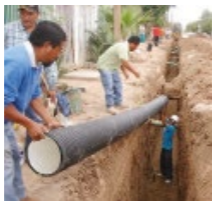
Figura 8. Bajado manual de tubería a la zanja
