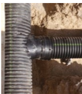
Figura 23. Conexión lateral hermética con Tee-In de 8 x 6 pulgadas.
