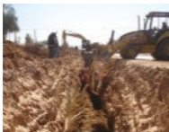
Figura 16. Colocación y compactación simétrica por capas
