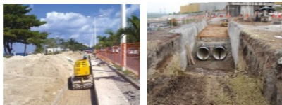
Figura 19. Compactación relleno final.
