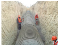
Figura 16. Colocación y compactación simétrica por capas
