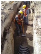
Figura 18. Compactación de relleno inicial
