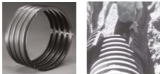
Figura 25. Instalación de cople abierto
