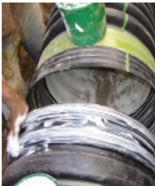
Figura 14. Colocacion de lubricante
