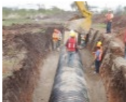
Figura 16. Colocación y compactación simétrica por capas
